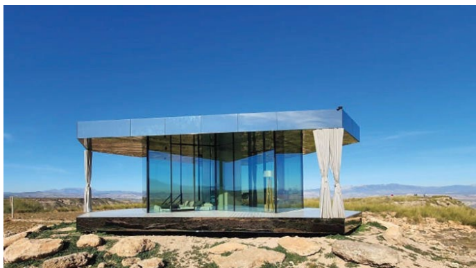
Imagen 3: Casa de cristal del desierto de Gorafe. Elaboración propia.
