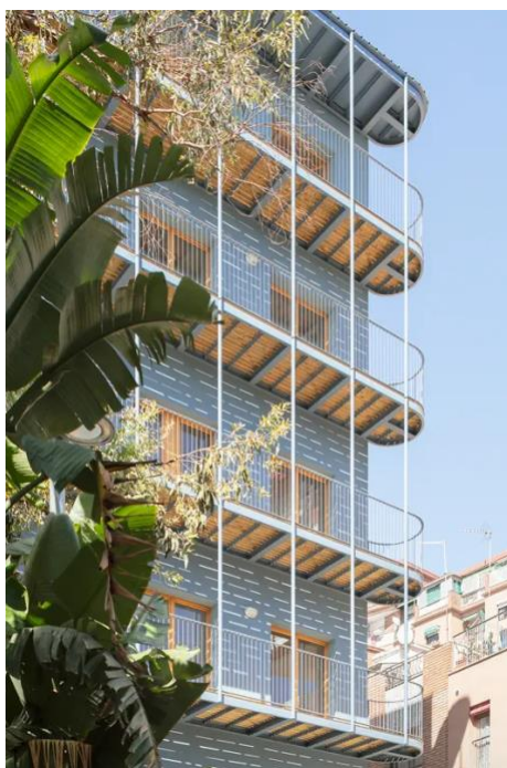
Imagen 17. Edificio de La Morada
