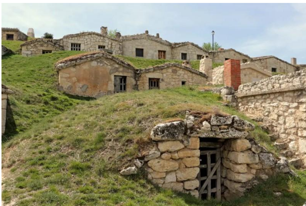
Ilustración 3. Bodegas subterráneas en Moradilla de Roa. Destinocastillayleon.es .
