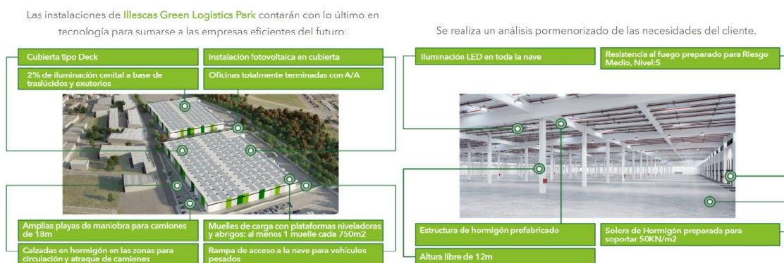
Ilustración 4. Imagen instalaciones” Illescas Green Logistics Park”. Internet
