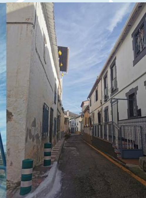
Interrupción de continuidad de aceras
