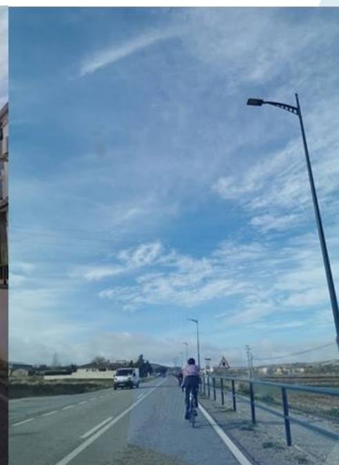
Inexistencia carril bici
