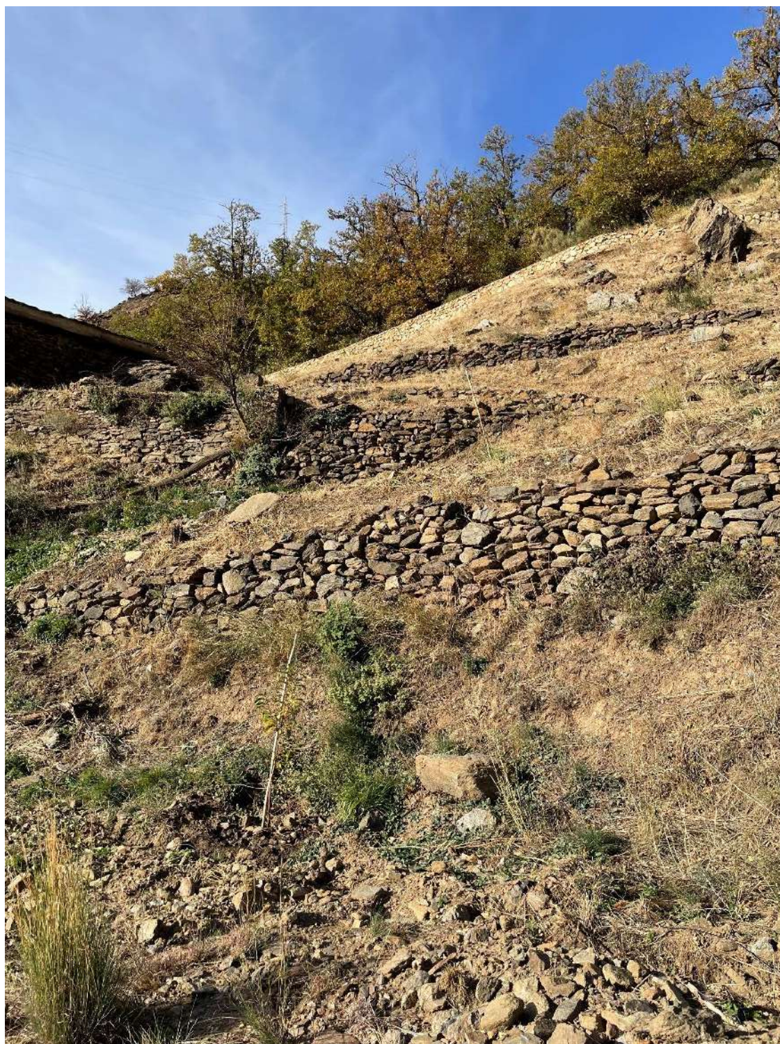
Imagen 77: Foto 14, estado actual de bancales 2. Fuente: propia.
