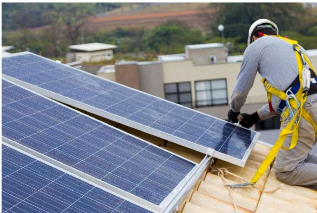
Imagen 40: Puesta de placas solares. Fuente: Google.
