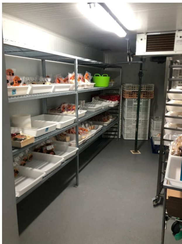
Sala de almacenamiento de Quesos Vico (Castilléjar). Elaboración propia
