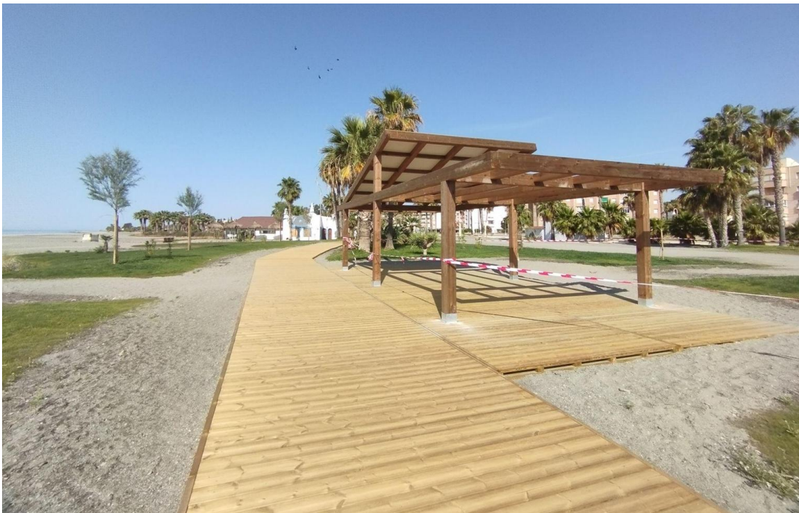
Imagen 3. Tramo de la senda litoral en construcción en Playa Granada (Motril). Fuente: Elaboración propia.
