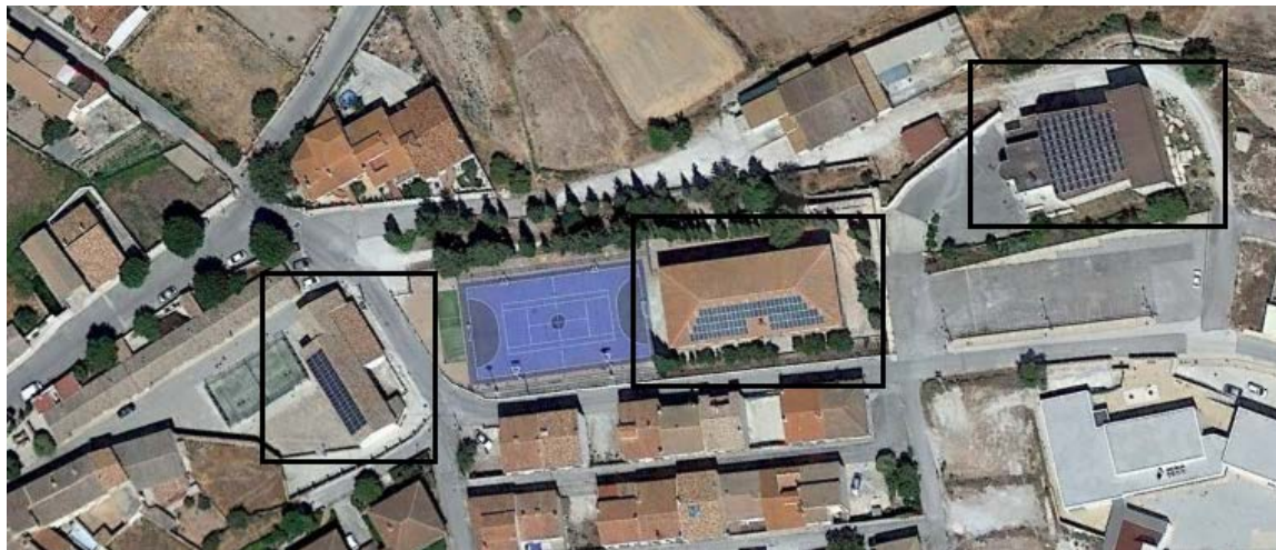
Vista de las instalaciones realizadas en Orce.
