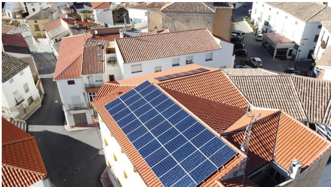
Instalación de autoconsumo y ACS existentes en el edificio del Ayuntamiento de Castilléjar.
