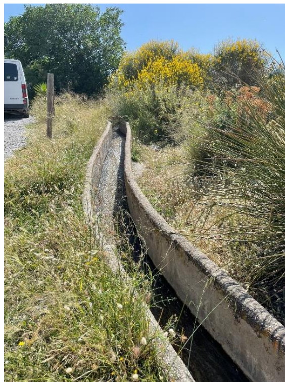
Ilustración 8 Rehabilitación de acequia de regadío
